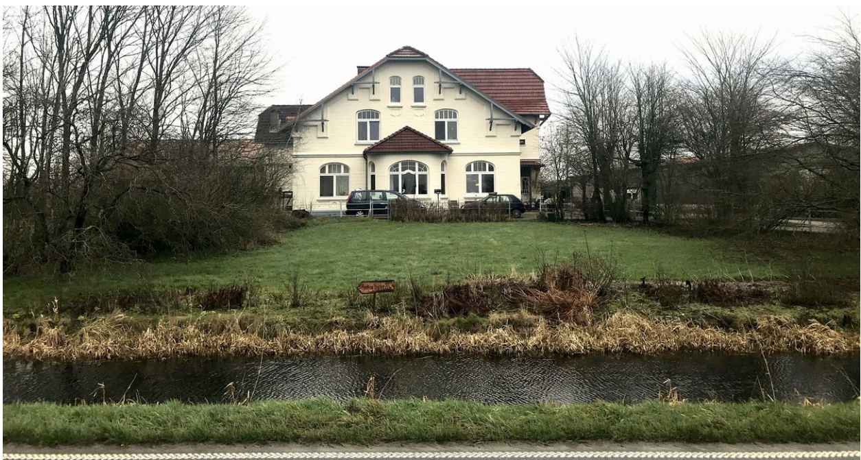
Abb. 1: Blick von der Landesstraße 149 auf das 1907 erbaute Haupthaus der Hofstelle Heim
