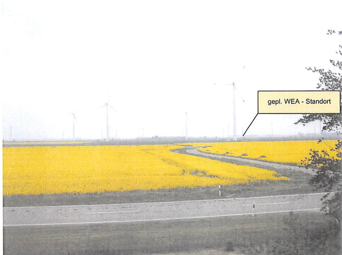
Bild 3 Blick auf das Plangebiet mit vorhandenen WEA (Blickrichtung Westen)
